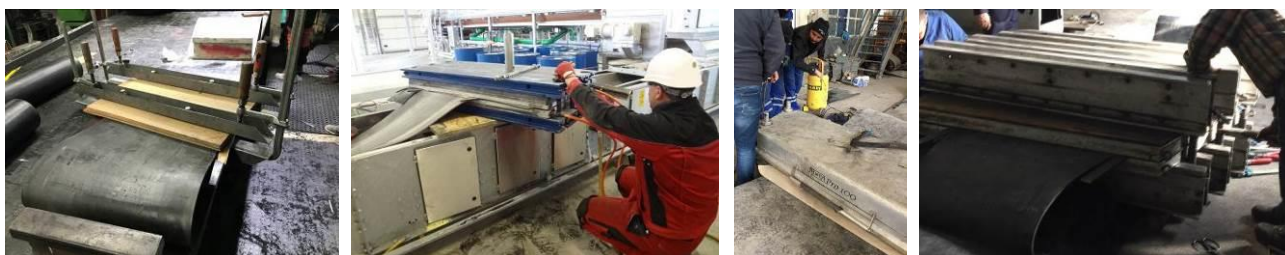
Empalme frio con unidad de fijacion
