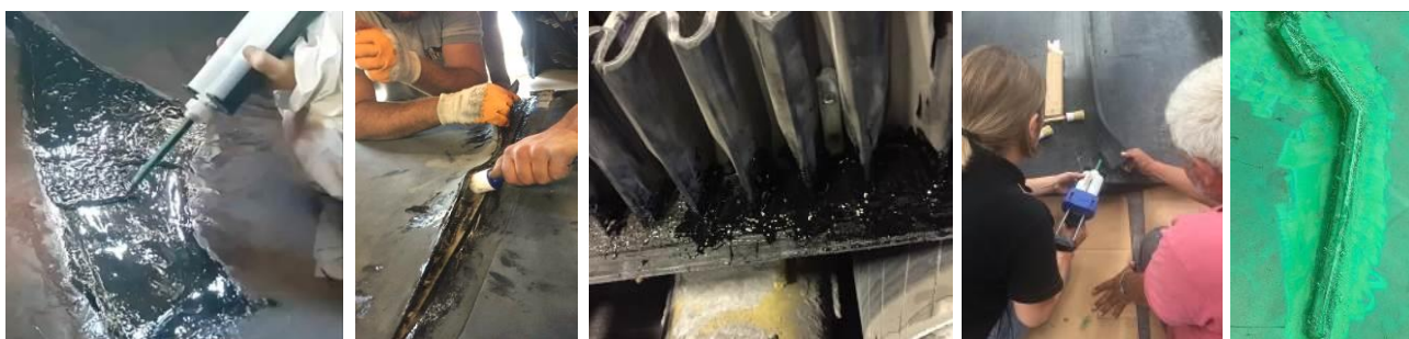
Delaminación de empalme
