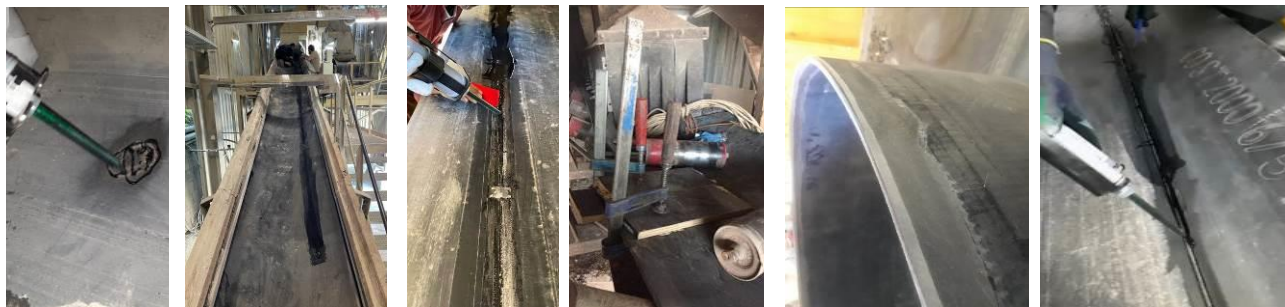
Reparación de grieta
